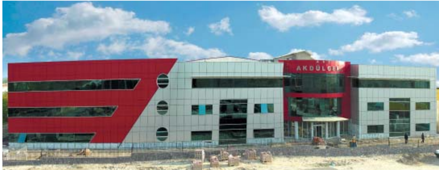
Aluminium-Verbundplatten lassen in der Fassadengestaltung – beispielsweise für Gewerbebauten – sehr viele gestalterische Möglichkeiten offen.
